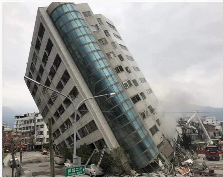
2018.02.06 花蓮地震--雲門翠堤大樓
